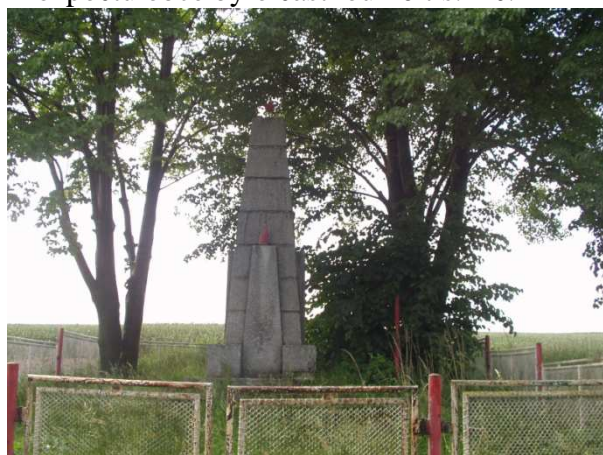
památník před opravou
